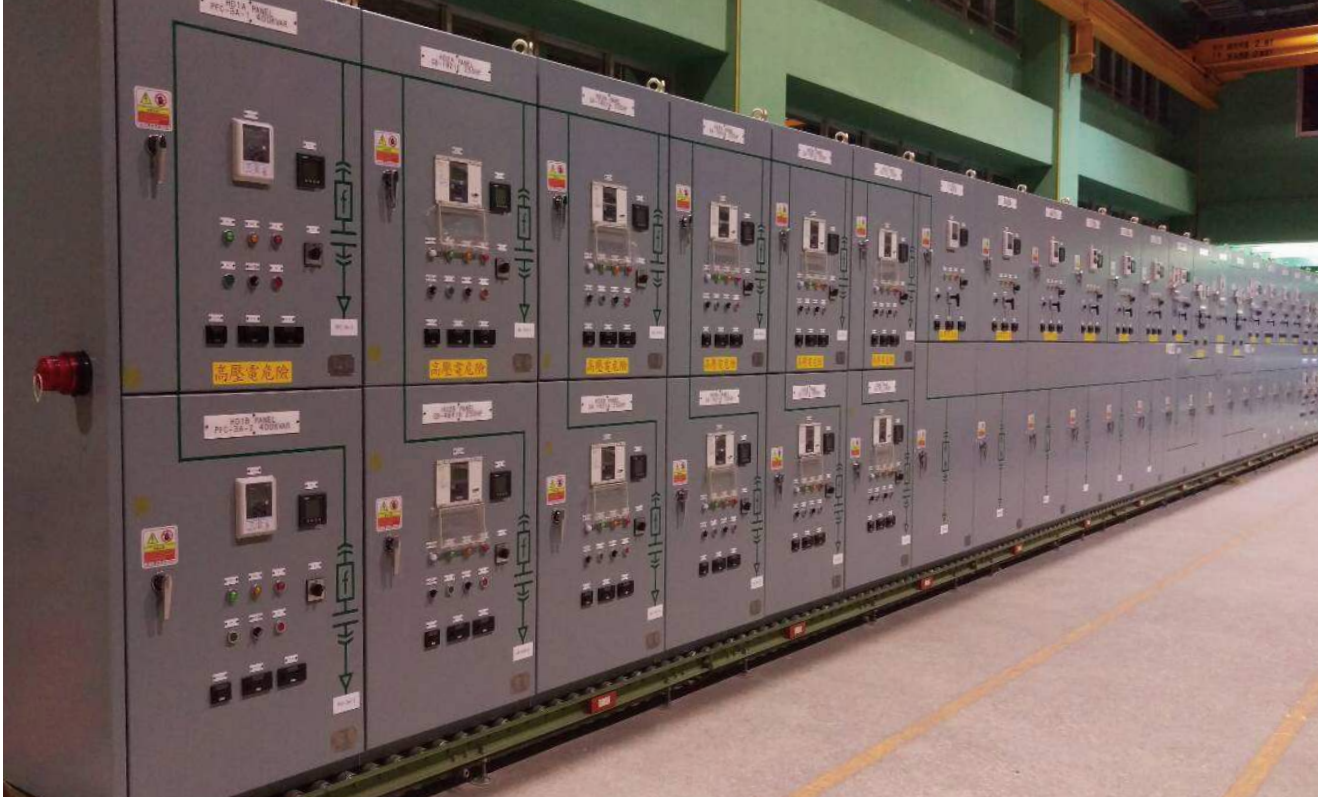
CNS 61439-2、IEC 61439-2 低電壓開關裝置、控制裝置
