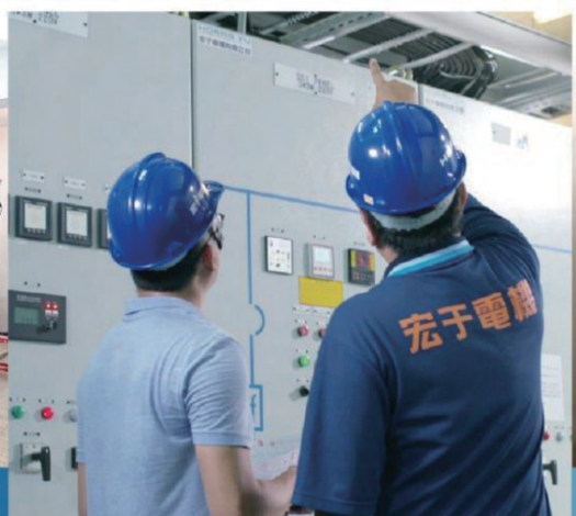
國立臺灣科技大學總變電站高壓設備電錶遷移汰換工程
