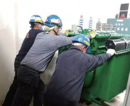
臺北榮民總醫院變電站老舊電力設備汰換
