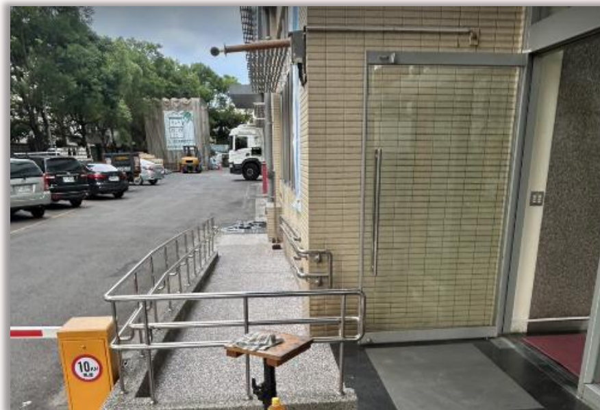
宏于電機於廠區出入口設置無障礙斜坡及雙側扶手設施，提供行動不便者及輪椅使用者安全、便利之通行環境。
