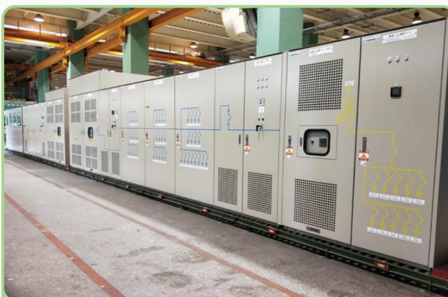
高壓閉鎖型配電盤
